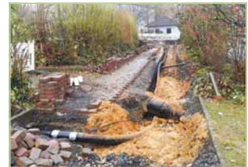
Leitungsverlegung für die Nahwärmeversorgung
